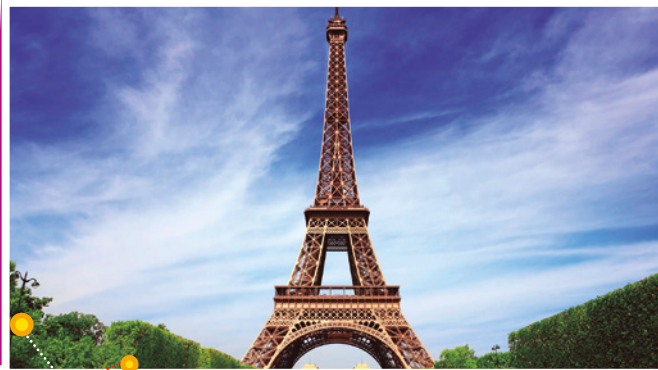
La torre Eiffel, uno de los monumentos más famosos del mundo, está construida en hierro y protegida contra la corrosión con varias capas de pintura.
